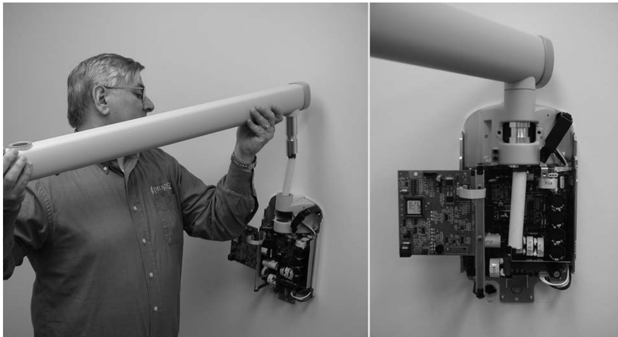
Рисунок 15 Установка горизонтального плеча
